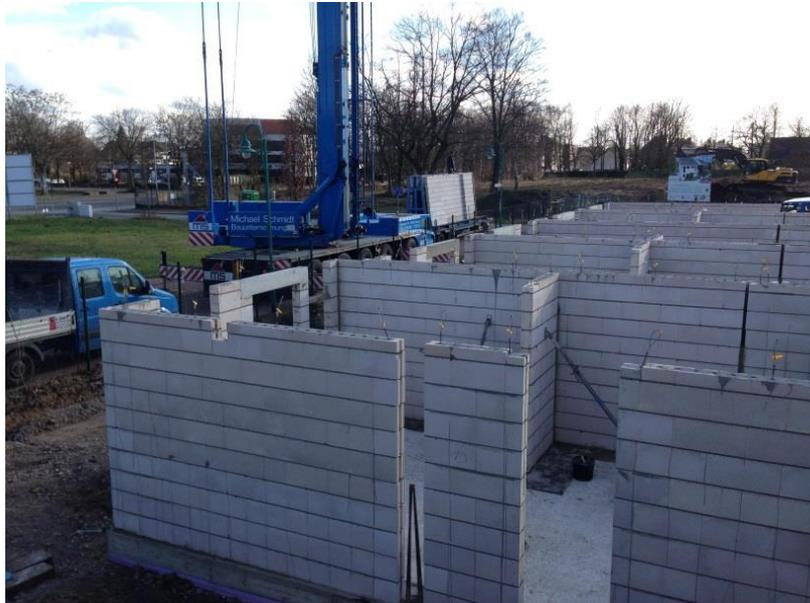
Rohbauerstellung mit Hilfe vorgefertigter Mauertafeln.
