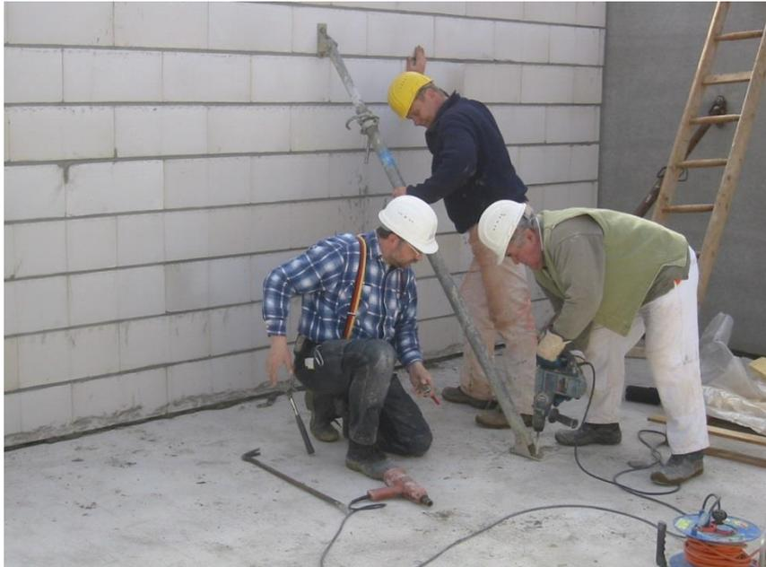
Sicherung der Wandelemente durch Schrägstützen.
